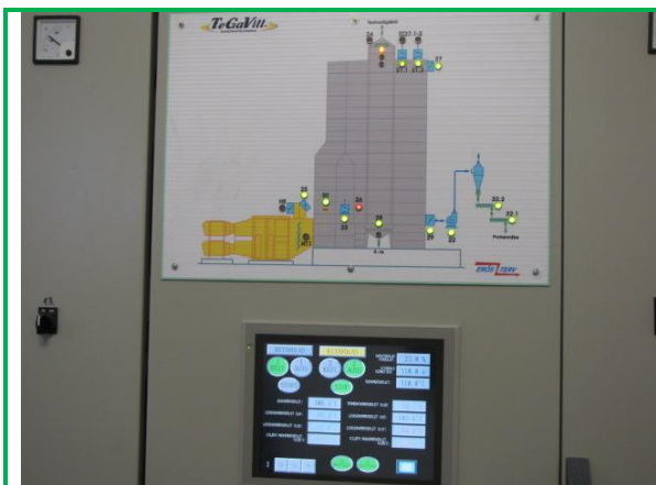
Forróvíz-levegő hőcserélő + hibrid hőlégbiztosítású gravitációs toronyszárító vezérlő képernyője
